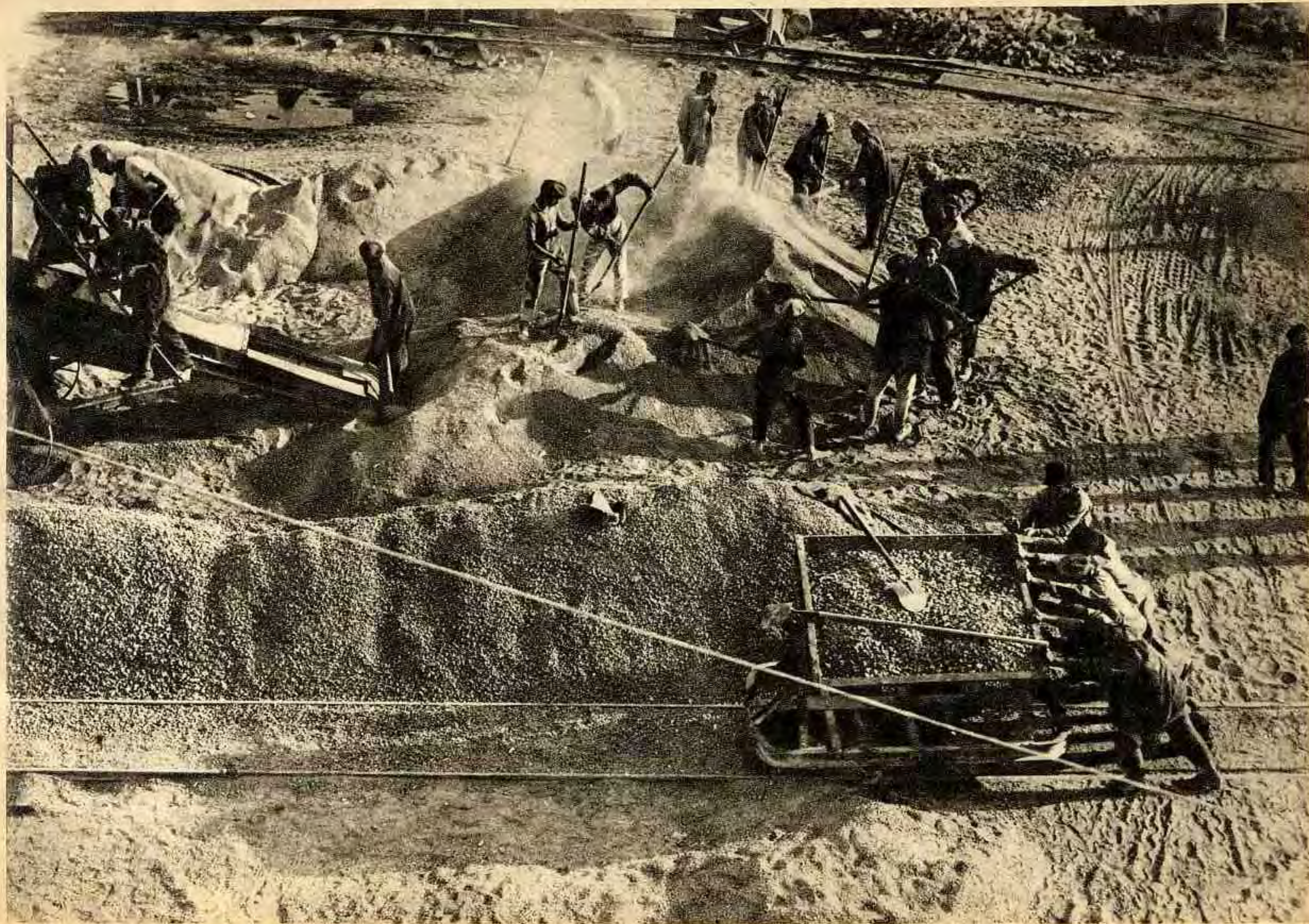
НА АСФАЛЬТОВОМ ЗАВОДЕ
