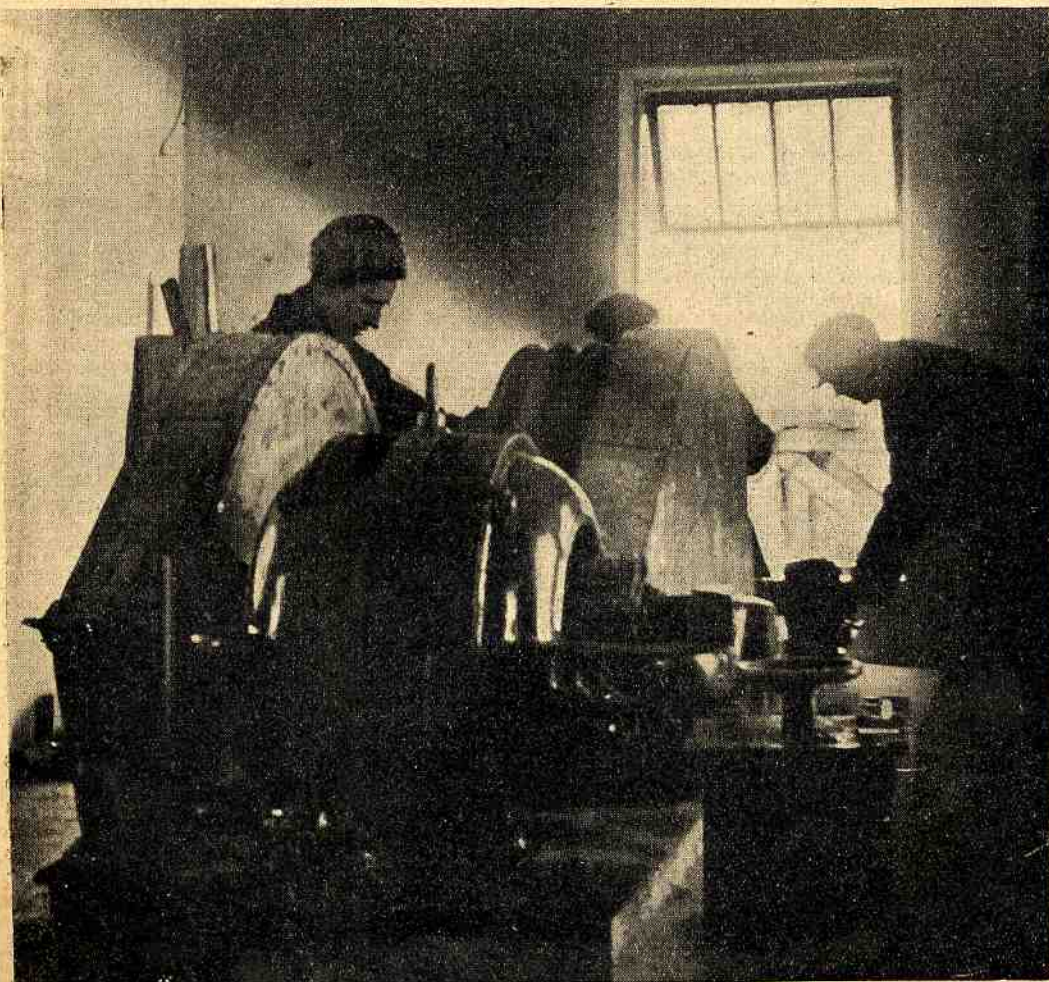
УСТАНОВКА НОВОЙ ТЯГАЛЬНОЙ МАШИНЫ В ШАХТЕ
