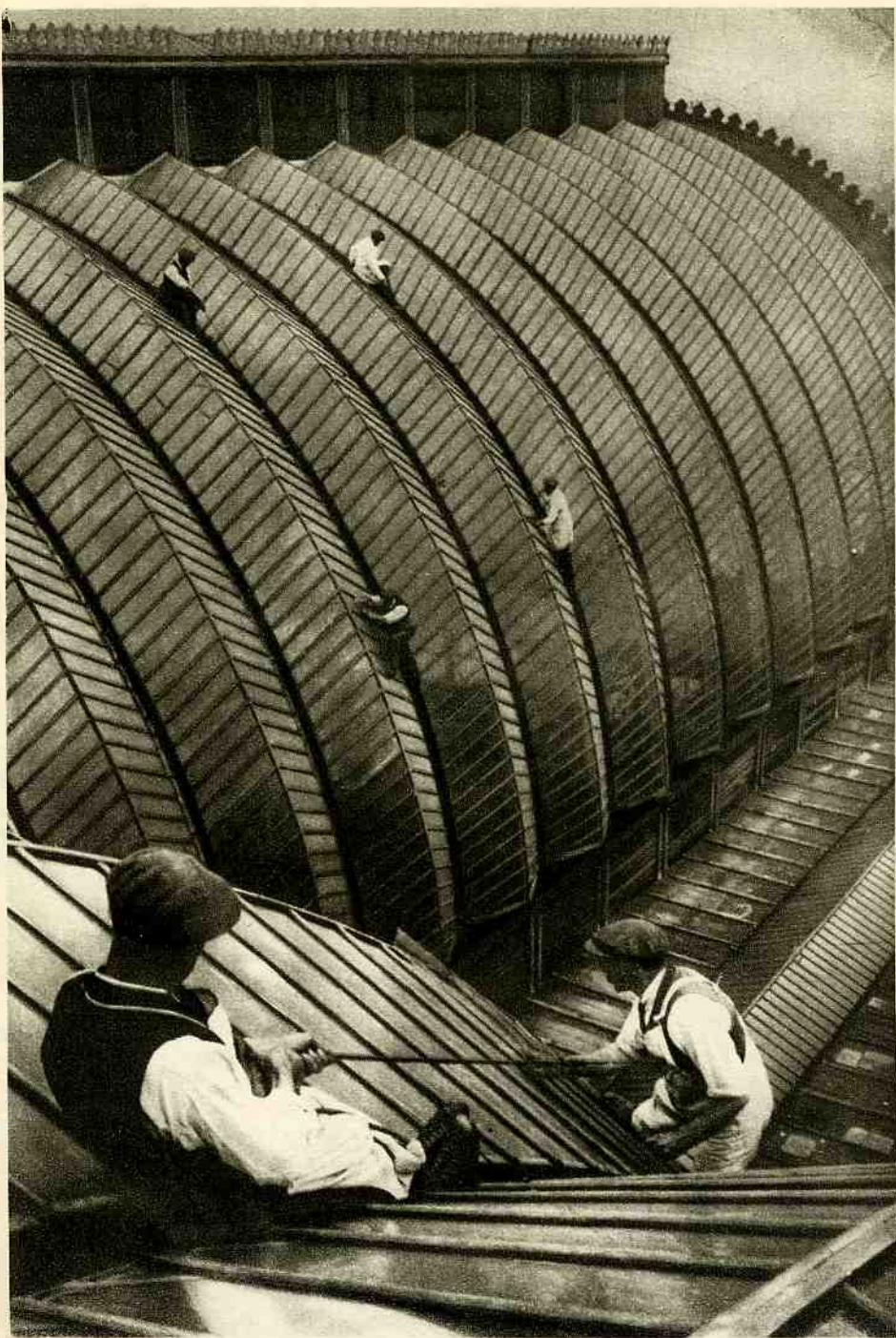
РЕМОНТ КРЫШИ БЕРЛИНСКОГО ВОКЗАЛА
