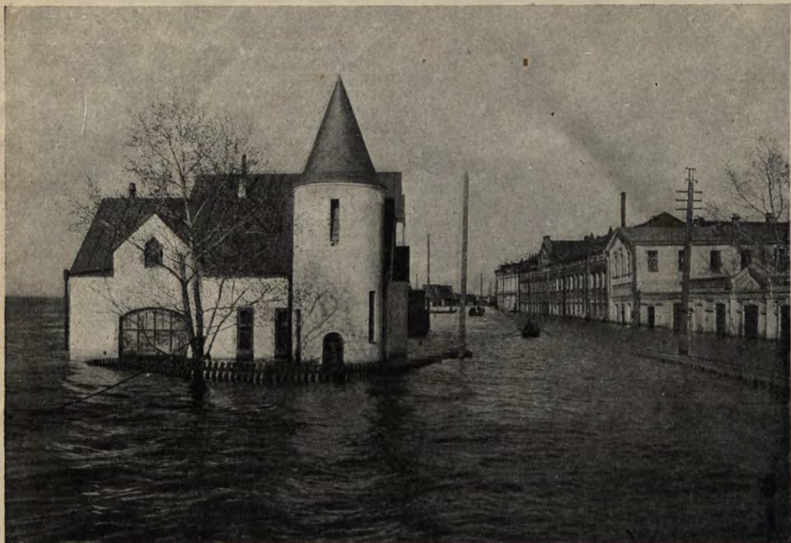
Наводнение 1926 г. в Нижнем-Новгороде. Затопленная Окская набережная
